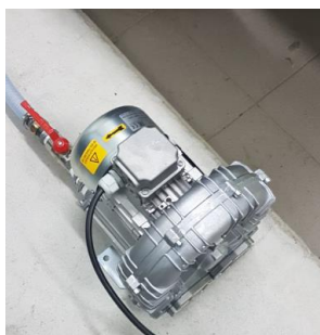
Slika 54: Puhalo za prezračevanje sit na izhodu biološkega reaktorja
