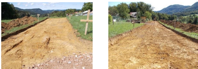
Sliki 22 in 23: Zemeljska dela
