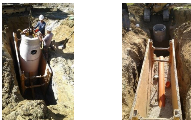
Sliki 24 in 25: Izvedba kanalizacije
