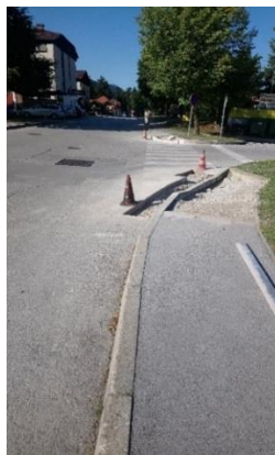
Sliki 40 in 41: Izvedba del prilagoditev in poglobitev pločnikov
